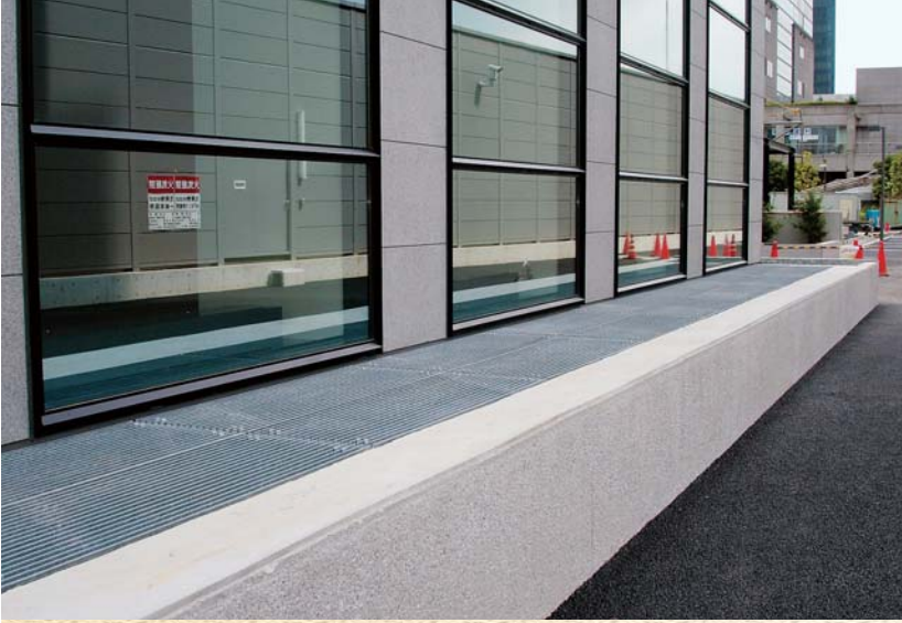
床板グレーチング
